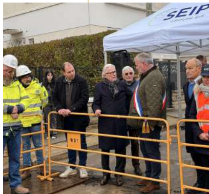
Chantier d'enfouissement coordonné à Bois-d'Arcy – 25 novembre
